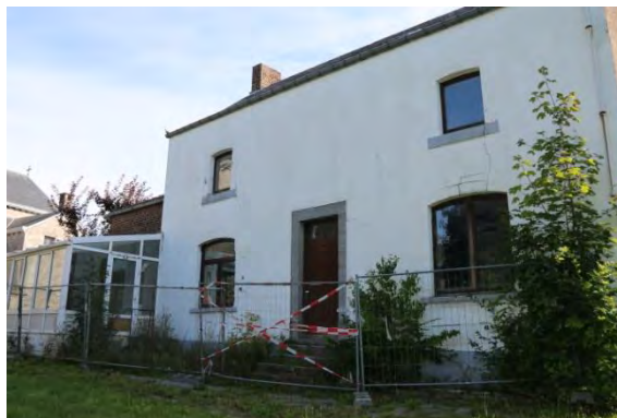
Vue arrière du presbytère
