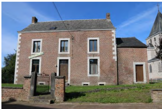
Vue avant du presbytère
