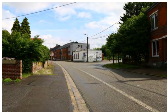
Vue de la voirie rue Le Marais – partie droite de la place
